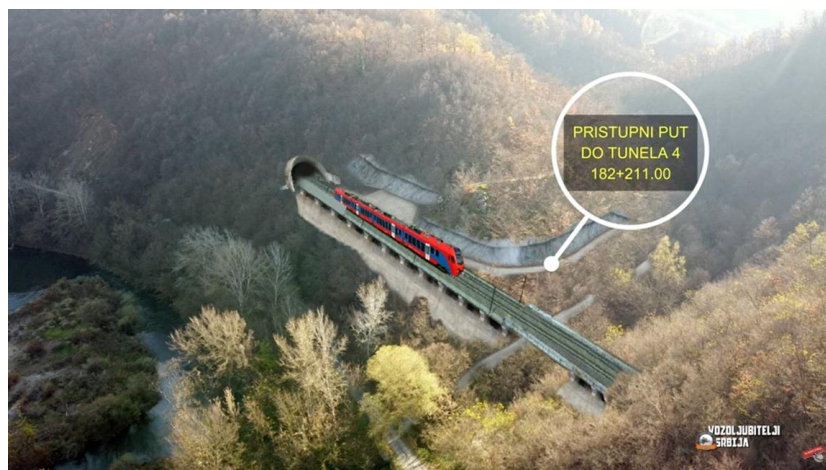
Slika 6: Ulazni portal Tunela br.4 sa pristupnim putem
