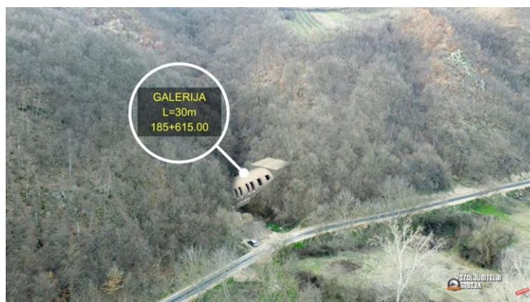
Slika 7: Galerija između ulaznog portala tunela br.4 i ulaznog portala tunela br. 5
