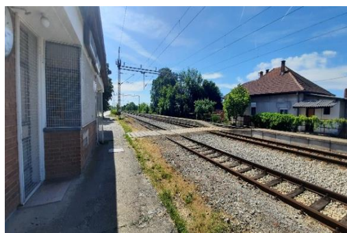
Mala Plana podeljena železničkim kolosecima sa objektima u neposrednoj blizini koloseka, izvor: ENOVA
