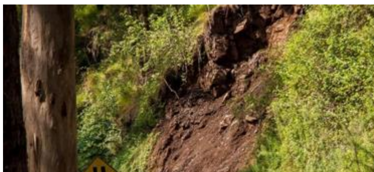
Slika 109: Klizište na lokalnom putu kod Kruševca posle poplava 2018. 168
