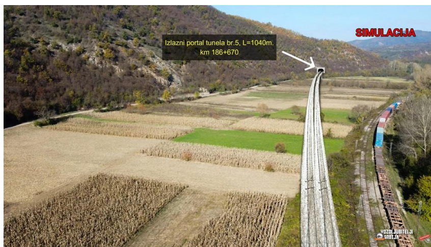
Slika 42: Izlazni portal tunela br. 5 i vijadukt kod Đunisa
