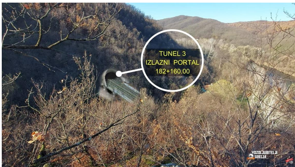
Slika 39: Izlazni portal tunela br. 3
