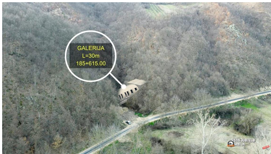
Slika 41. Galerija između ulaznog portala Tunela br. 4 i ulazni portal tunela br. 5
