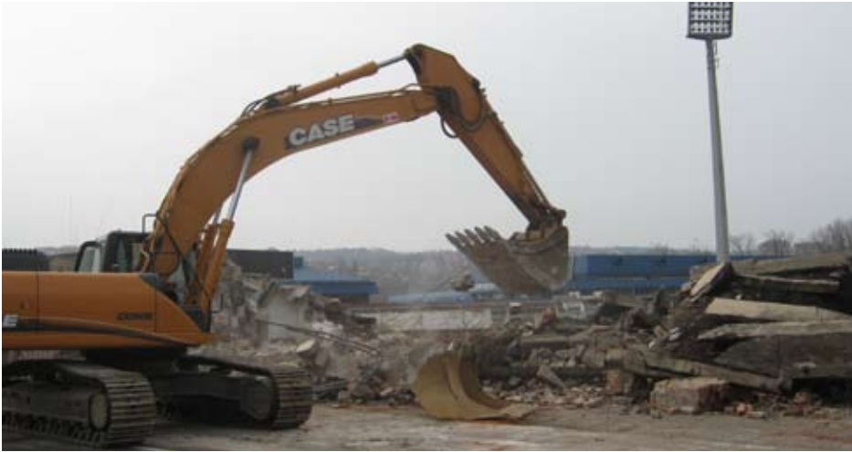
Почетак радова: рушење источне трибине
