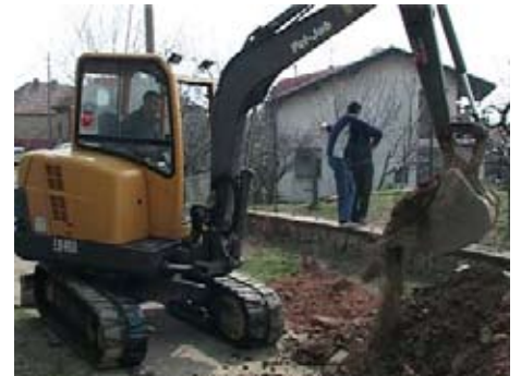
Радови на изградњи канализационе мреже у селу Горње Међурово
