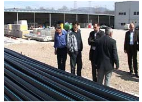
Почетак радова на реконструкцији водоводне мреже у селу Малча
