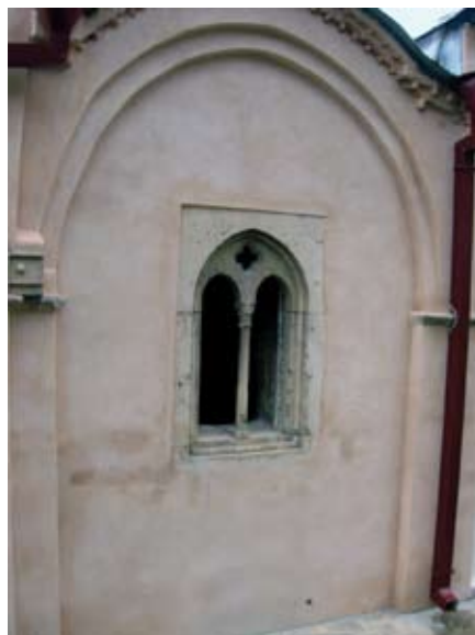
Сл. 3. Бифора из XIV века са скинутим дозиданим речним каменом и малтером дозиданим у XVII веку. Фреско-малтер, полеђина фреске на чијем је делу у унутрашњем севернозападном делу наоса нише насликан српски патријарх Јеферем. Са источне и западне стране допрозорника, ослобођене су сазидане фреске из XIV века. Црква Св. Димитрија, северозападна страна, Пећка патријаршија. Снимио: Р. Петровић, 2006. године.
