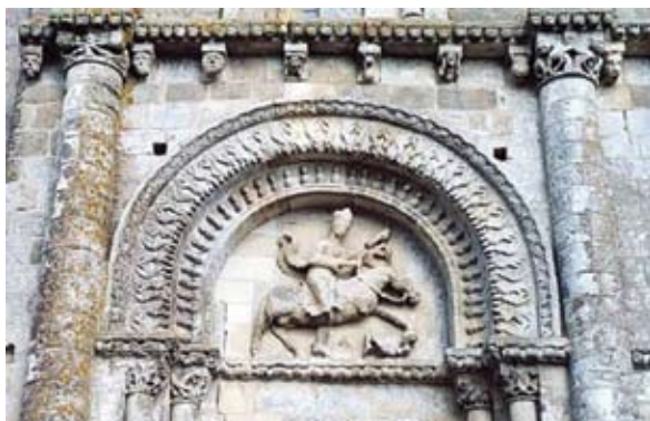
Fig. 9. Parthenay-le-Vieux, Saint-Pierre, facciata
