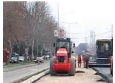
Реконструкција Булеvara Зорана Ћинђића, од раскрснице са улицом Војводе Мишића до Булеvara Цара Константина највећа је инвестиција у саобраћајну инфраструктуру у последњих 20 година
